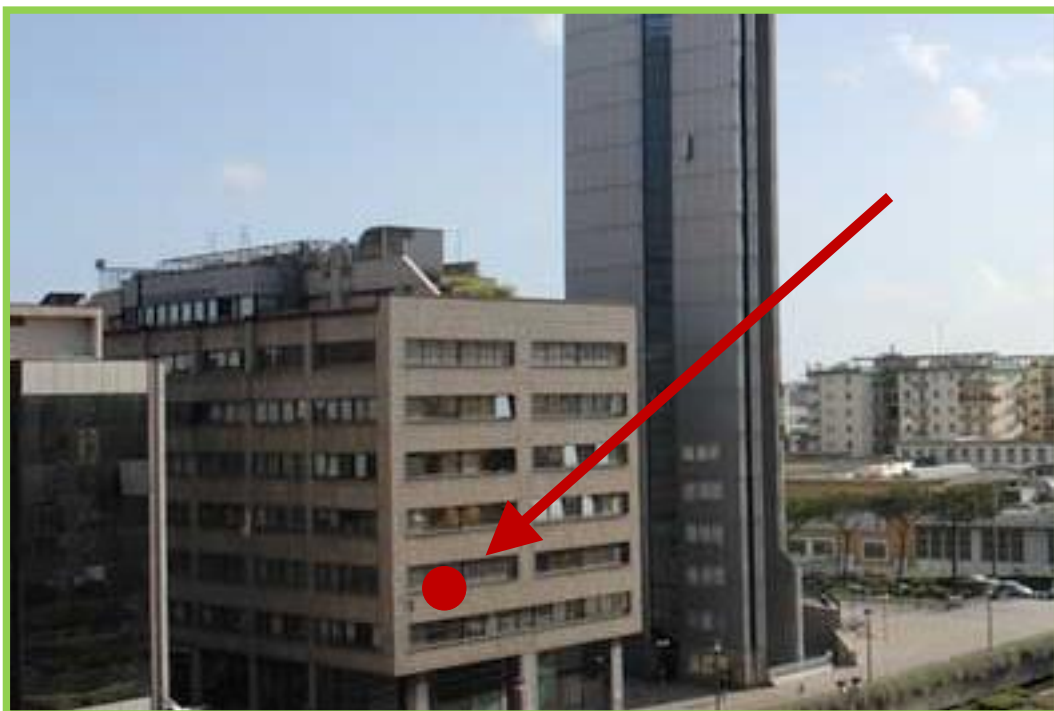
Figura 2 - Facciata della sede uffici, Isola A2 Centro Direzionale di Napoli (CDN), secondo piano
