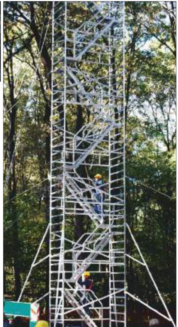
Torre osservatorio di ricerca ambientale per rilevamento atmosferico Collaudata fino a 24 mt.
