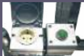
Presenza elettrica da 230V posizionata sul cestello
